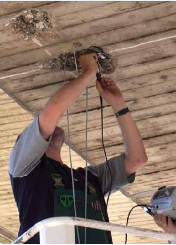
Anbringen der Dehnungsmessstreifen (DMS) auf die freigelegten Spannglieder.
